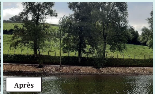
Reprise des berges érodées par le temps, le batillage, les rats musqués et ragondins, le système racinaire des arbres...
