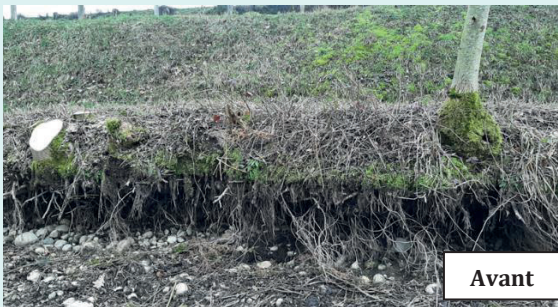
Reprise des berges érodées par le temps, le batillage, les rats musqués et ragondins, le système racinaire des arbres...
